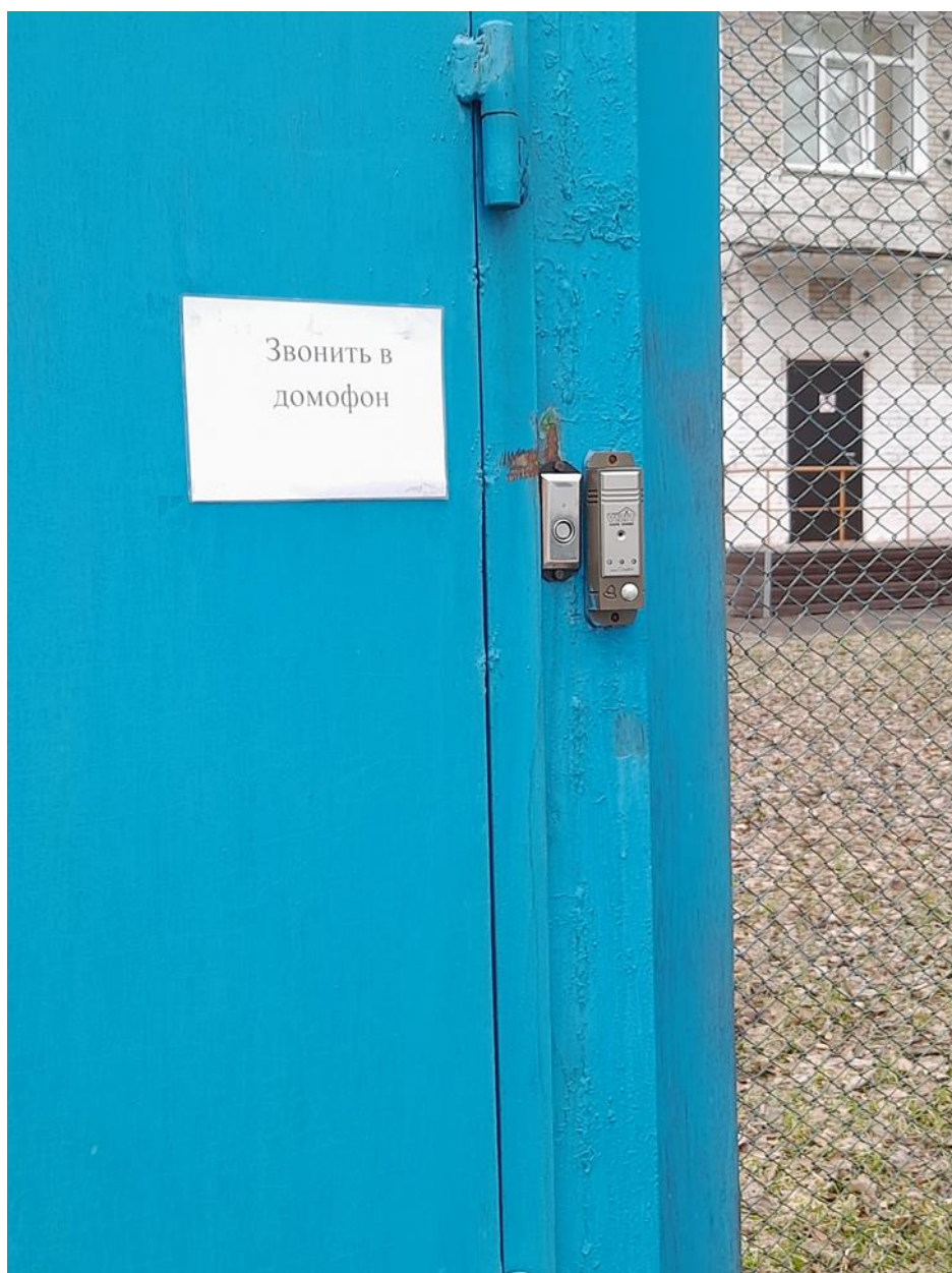
Видеодомофон на центральном входе на территорию детского сада.
